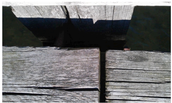
Sidledsförskjutning över balkstöd
